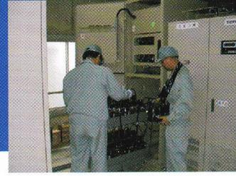
Industri-industri pada umumnya menggunakan energi listrik sebagai tenaga utama penggerak proses produksi. Pada beberapa perangkat, diperlukan kesinambungan suplai listrik yang tidak terputus. Pada sistem yang demikian diperlukan Uninterruptible Power Supply (UPS). Sumber energi UPS pada umumnya adalah battery atau accu. Pada skala kecil, UPS hanya menggunakan 1 cell. Namun, pada skala industri yang cukup besar, digunakan puluhan battery yang dirangkai secara seri.
